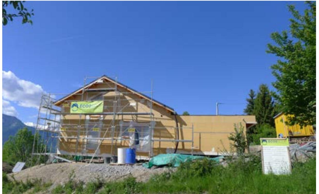
▲ Embrun, chantier de construction d'une maison à ossature bois isolée en paille
